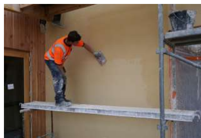
Enduits à la chaux
