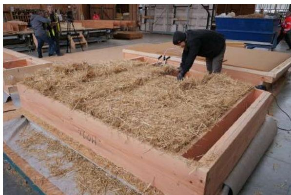
Préfabrication panneaux paille
