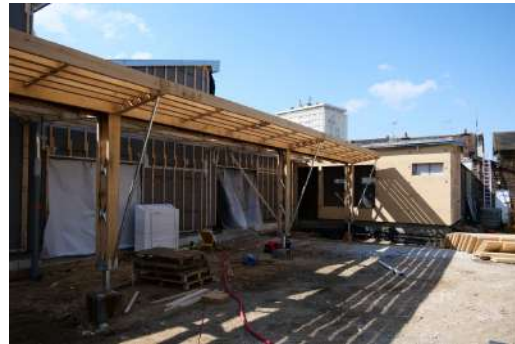
Cour, auvent et réhabilitation
