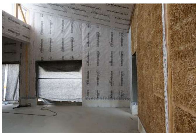
Intérieur pendant chantier
