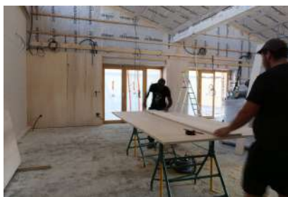
Pose des panneaux de peuplier
