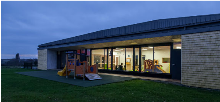
Crèche en paille dans le Loir et Cher. Elle a obtenu la « certification Passivhaus » ou maison passive. Les appareils de chauffage n'y sont pas nécessaires. ©Corentin Desmichelle.
