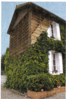
La maison Feuillette à Montargis.
