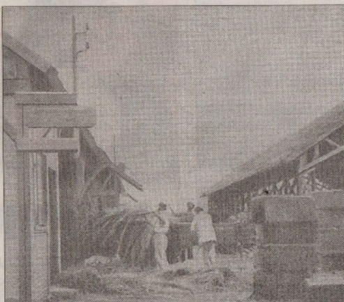
La confection des moellons de paille pour le remplissage des murs. Une machine spéciale comprime la paille (1921).
