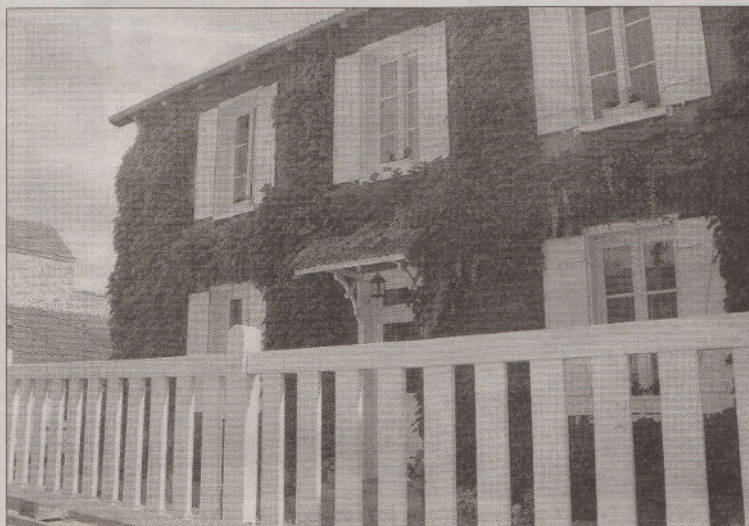
Malgré le lierre qui recouvre les façades - ce qui donne un charme supplémentaire à l'édifice, les enduits ne présentent aucune détérioration (2012).
