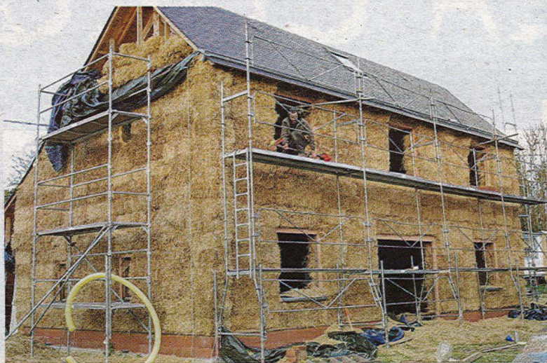
GOULIEN (FINISTÈRE). Au final, une maison en paille coûte le même prix que la filière traditionnelle.
