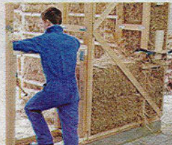
Ci-dessus, on peut voir les différentes étapes de la construction d'une maison en paille
